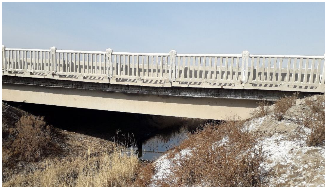
Рис.1. Общий вид моста.
