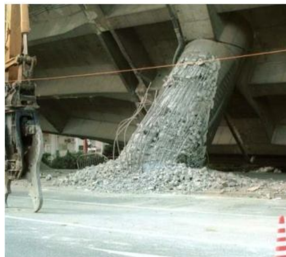
Расм 1. Зилзила таъсирида кўприкнинг бузилиши
