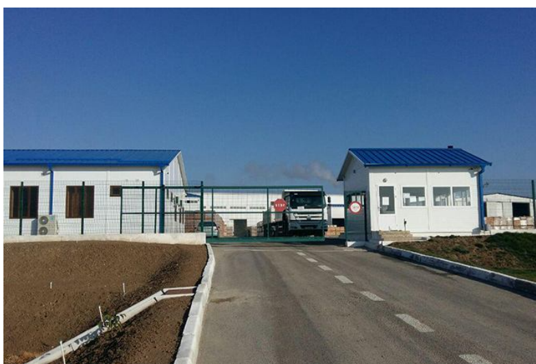
Рис.3. Фрагмент возведенных экспериментальных зданий из поризованного кирпича
