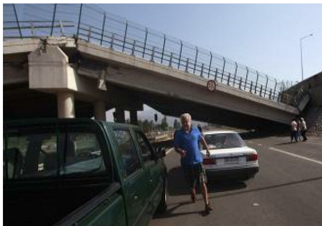
Расм 2. Зилзила таъсирида кўприкни чекка устунини бузилиши
