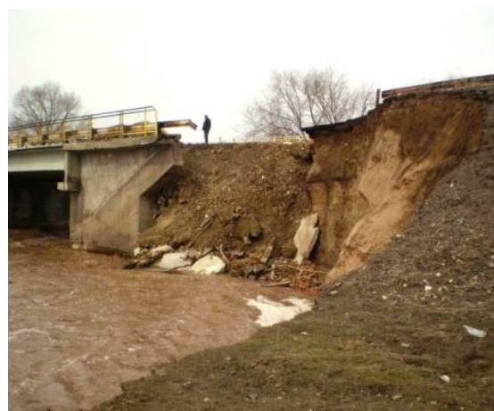
Расм 2. Зилзила таъсирида кўприкни чекка устунини бузилиши
