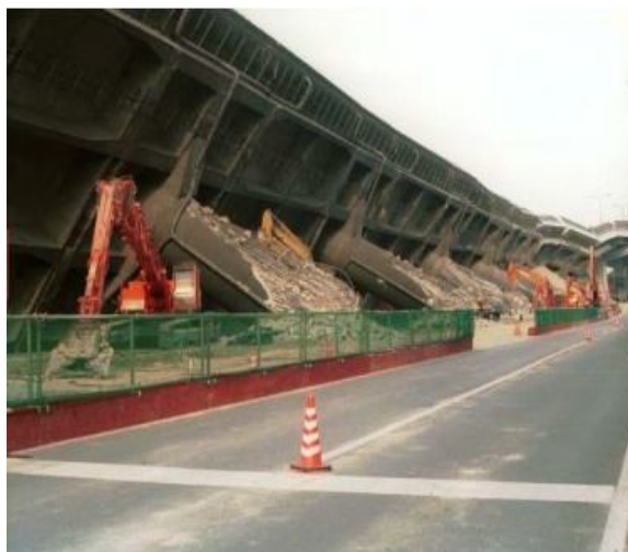
Расм 1. Зилзила таъсирида кўприкнинг бузилиши
