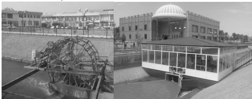
Рис.3. Общий вид Микро-ГЭС- 3 в сборе с передаточными механизмами, генератором и в АКВА помещении
