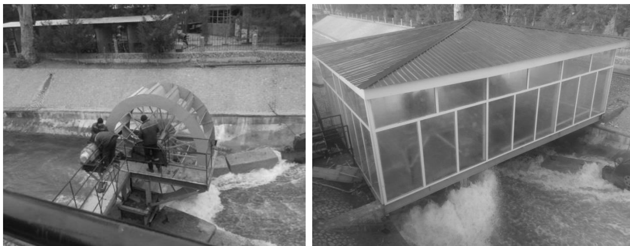
Рис.2. Микро-ГЭС-2 в сборе с редуктором, генератором и в АКВА помещении
