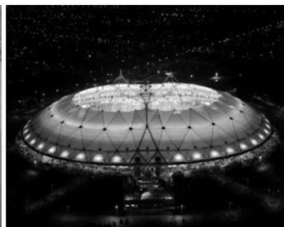
Рис. 3. Крыша стадиона «La Plata Stadium» в Аргентине
