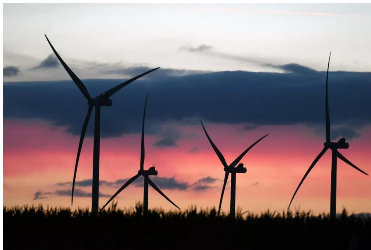
2-rasm. Shamol elektr stansiyasining umumiy ko'rinishi.
