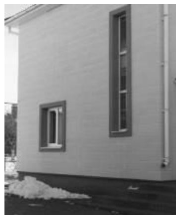
Рис. 4. Жилой дом после монтажа фасадной термоплитки.
