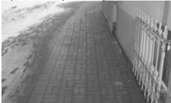
Рис.3. Отмостка здания без утепленного фундамента
