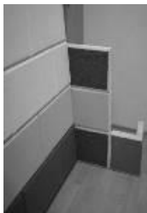
Рис. 1. Внешний вид фасадной термоплитки Рис. 2. Монтаж фасадной термоплитки на стену здания.
