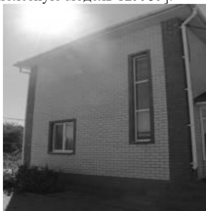
Рис. 3. Жилой дом до монтажа фасадной термоплитки.
