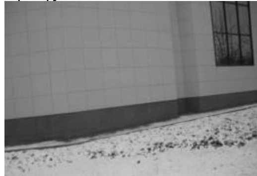
Рис. 4. Отмостки здания с установленным теплоизоляционным фундаментом
